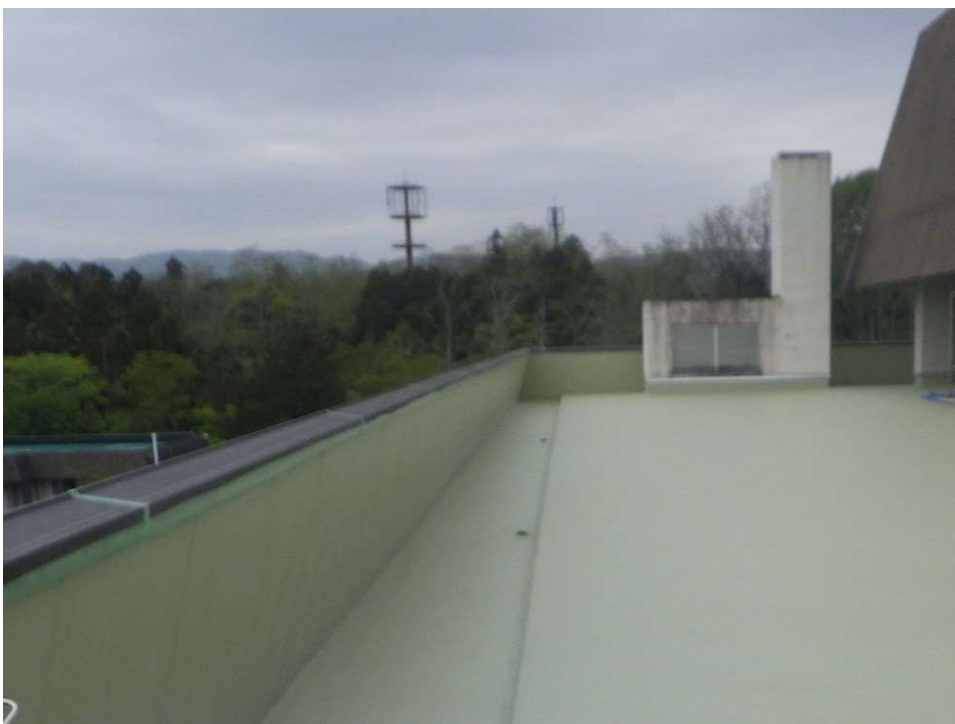
完成写真 本館棟 南面 YC3～5・XH6～12
