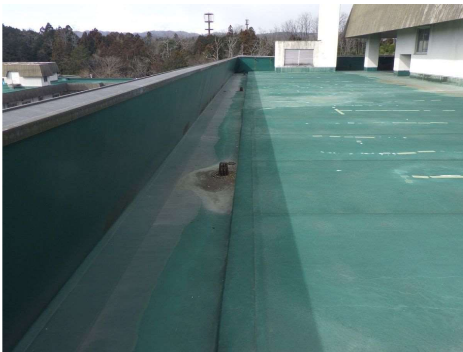
着手前 本館棟 南面 YC3～5・XH6～12
