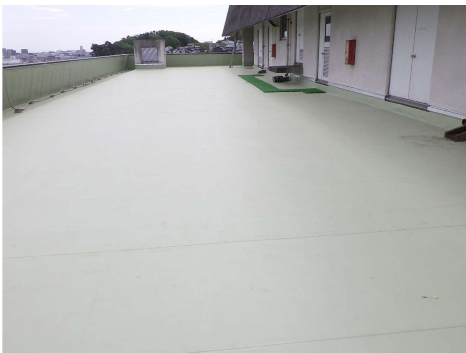
完成写真 本館棟 北面 YC5～7・XH6～12
