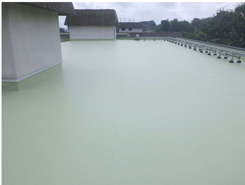
完成写真 北病棟
