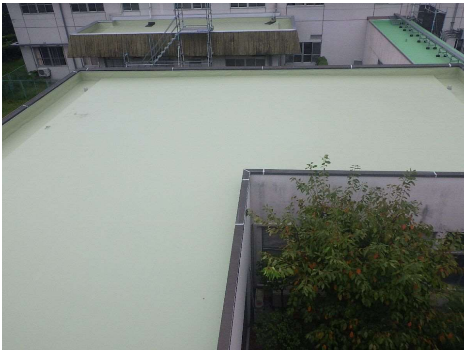
完成写真 ソーシャルセンター棟 1F
