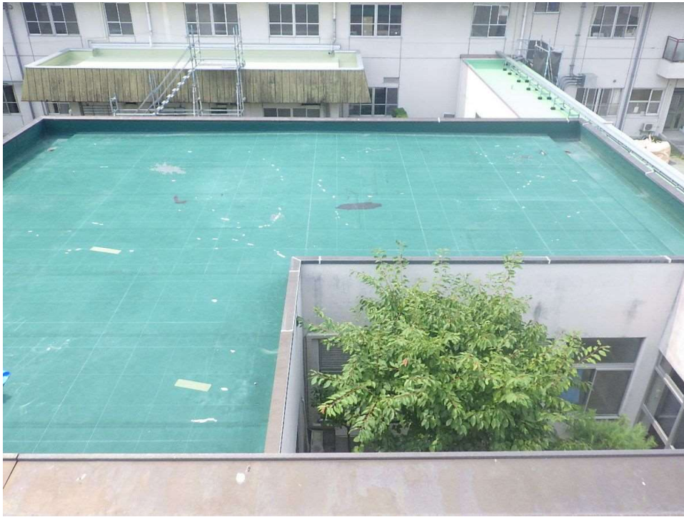
着手前 ソーシャルセンター棟 1F
